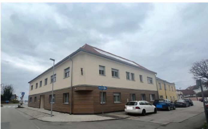
Das Topfhaus nach der Generalsanierung
