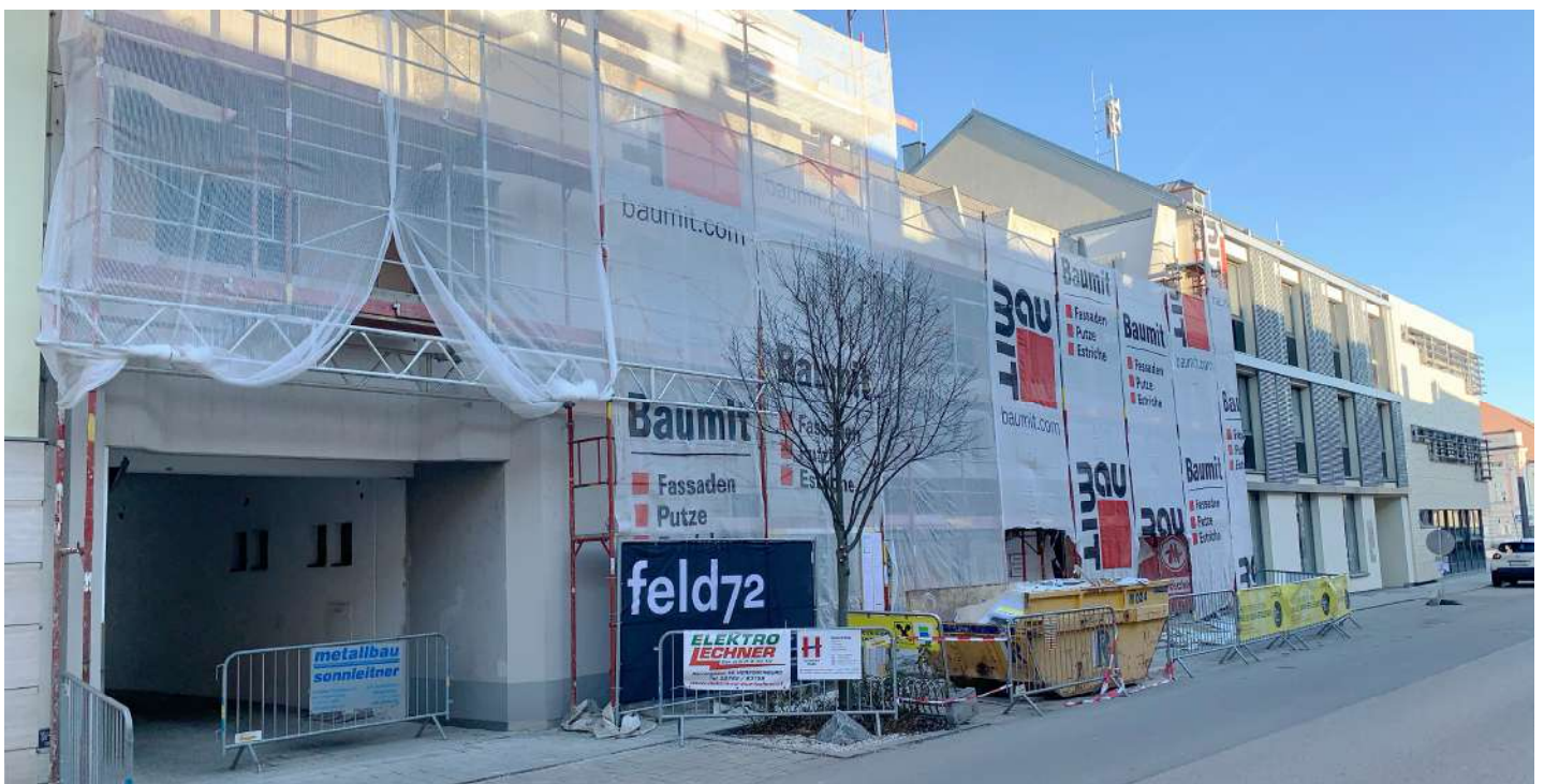
Vorsicht Baustelle! Bereits in wenigen Wochen erstrahlt die Raiffeisenbank in neuem Glanz
